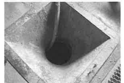
ショベルローダーで配合の指示通り土がすくわれ、床にあいた穴から下に流れ階下にある粉砕機に入れられる
